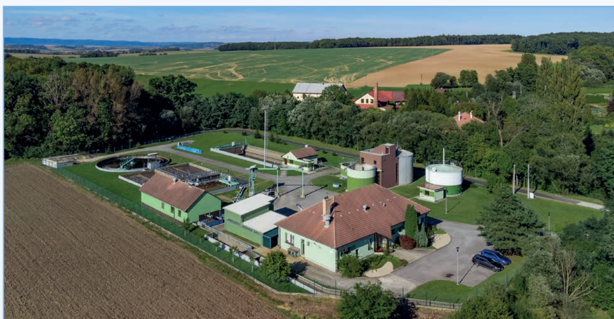
ČOV Bystřice pod Hostýnem
